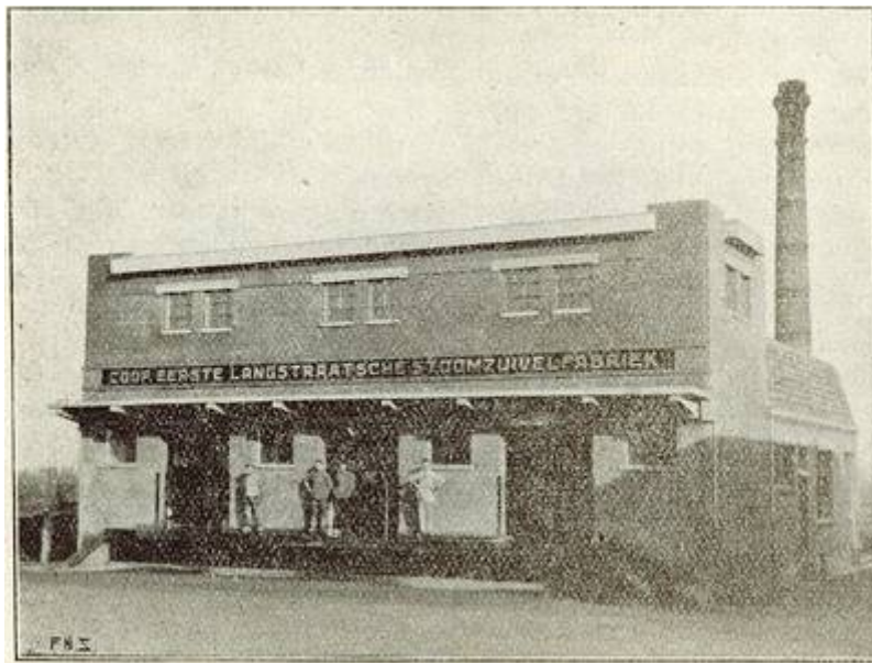
Coöp. zuivelfabriek Drunen vlak na de verbouwing van 1929.
