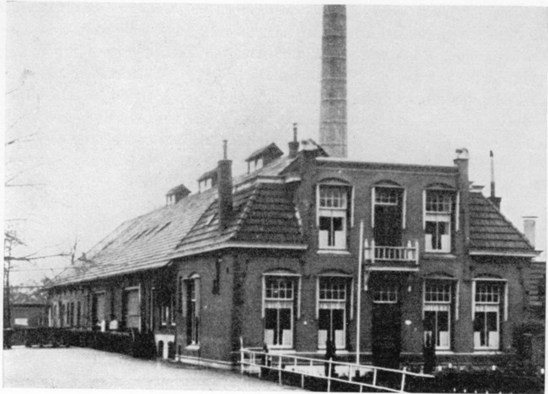
DE OVERGENOMEN FABRIEK TE BEILEN
