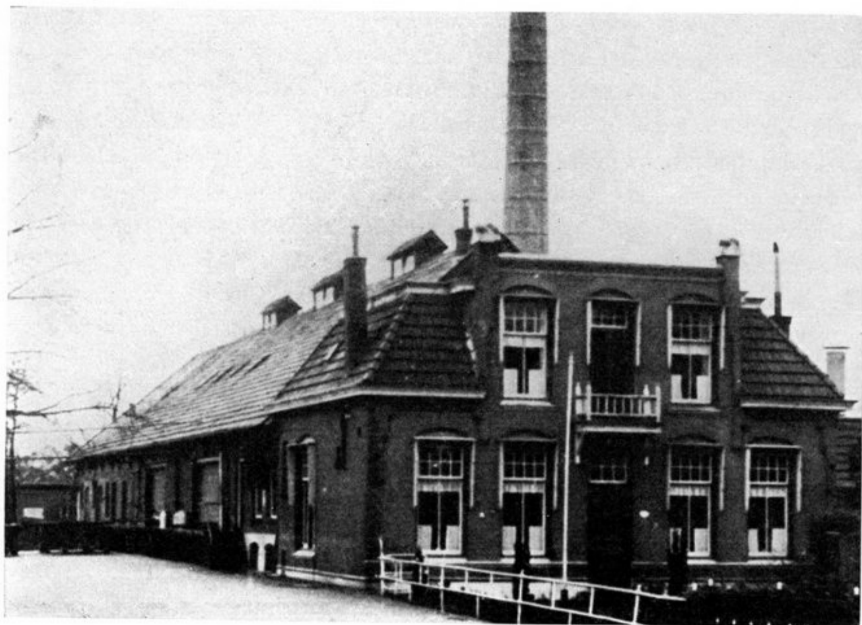
DE OVERGENOMEN FABRIEK TE BEILEN
