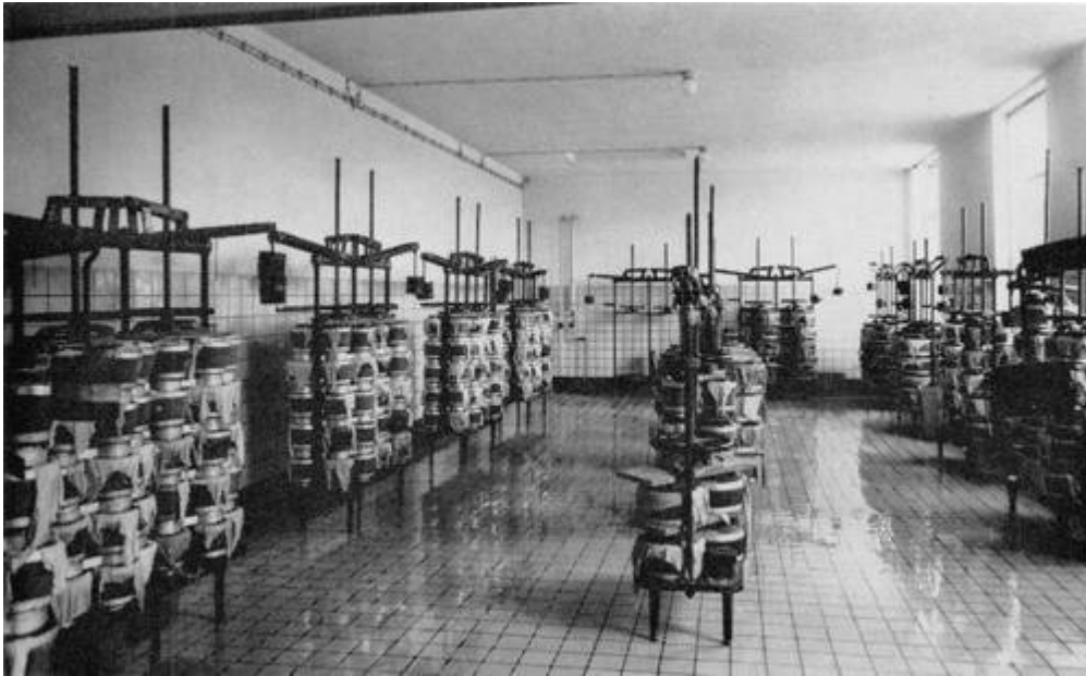
Afb. 24 De opstelling van de Engelse kaaspersen.
