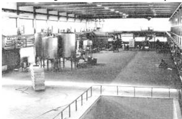
Interieur van de technohal.
