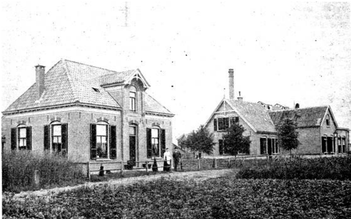
Fabriek met directeurswoning na de verbouwing van 1901
