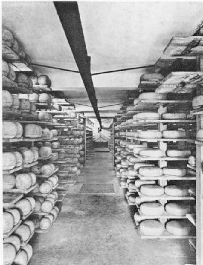
Kaaspakhuis. Door de luiken in de vloer werden de kazen vanuit de eronder liggende pekelder naar boven gegooid, waar ze werden opgevangen. Aan de zolder een rail, waaraan een bak hing, waarin de kazen naar het raam werden vervoerd. Door het raam rolden of gleden de kazen op een wagen, waarop ze naar het spoorwegstation werden gebracht (1928)
