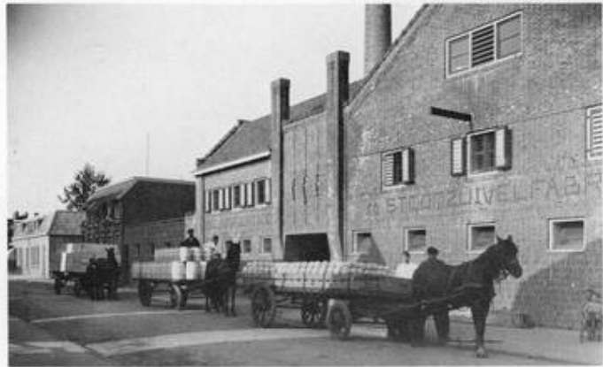
Achterfront der fabriek (1928) met links daarvan dubbele personeelswoning, gebouwd in 1911
